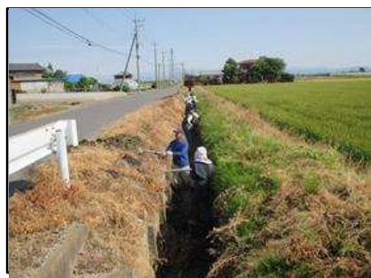
( 水路の泥上げ作業 )
