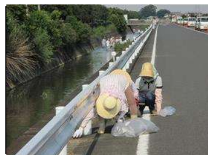
( 水路の清掃作業 )
